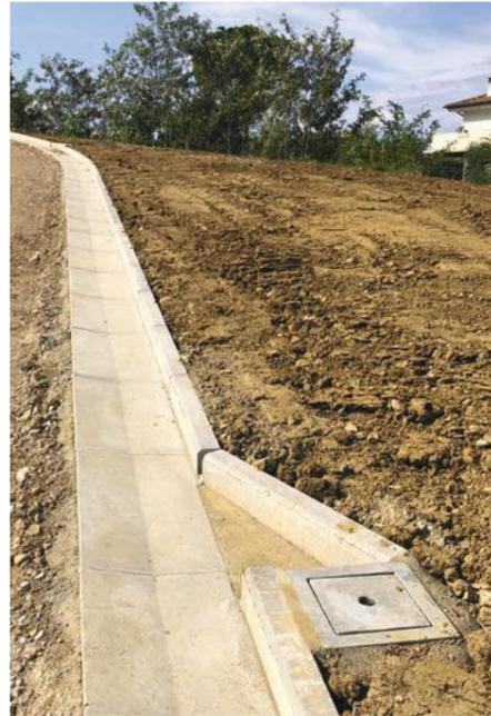
Zanelle per il deflusso delle acque realizzate in cemento vibrato. Si adattano facilmente a qualsiasi sottosuolo. Durevoli agli agenti atmosferici e alle sollecitazioni. Basso assorbimento di acqua che garantisce una resistenza ai cicli di gelo e disgelo, resistenti al passaggio di carichi saltuari. Posa in opera facile.
