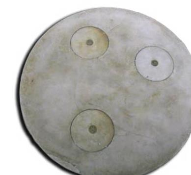
Tappo degrassatore circolare, elemento vibrato e armato in conglomerato cementizio 425, tre fori di ispezione con tappo e possibilità di raccolta degli oli residui.
